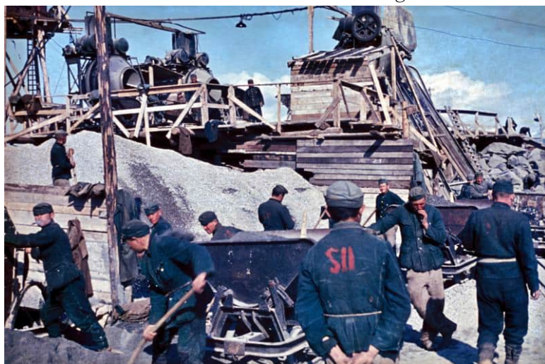
Kriegsgefangene beim Bau der deutschen Turmbatterie Oerlandet in Norwegen, 1942
